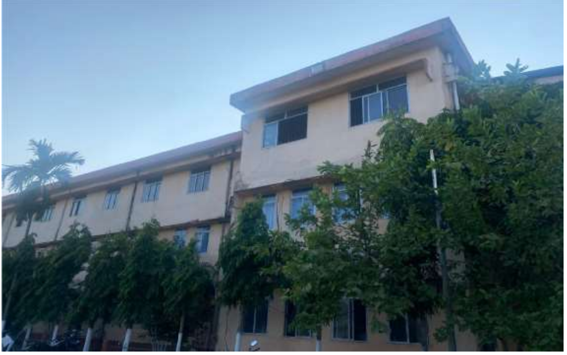
আই টি আই ৰ সন্মুখ দৰ্শন
